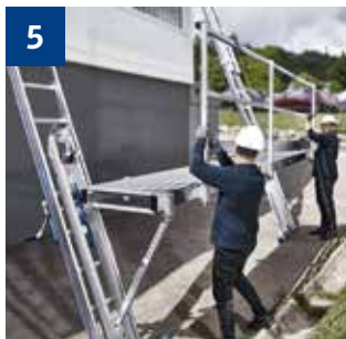
5 Geländer in Arbeitsbühne einstecken und bei Bedarf Personen-Fangnetz oder Rückseitengeländer anbringen.
