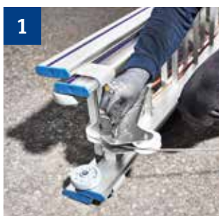
1 Umlenkrolle und Seilwinde an den Stützleitern montieren und Seil einfädeln.
