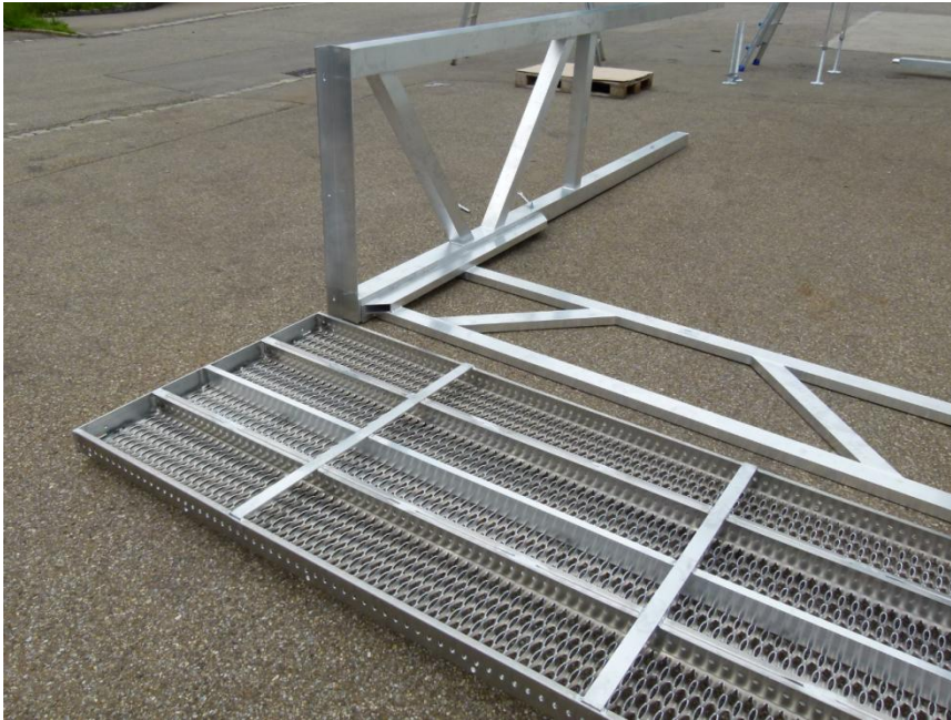
Abb. 30: Aufbau der Stütze für Zwischengeschoss: Stützen und Verbinder fertig aufgebaut
