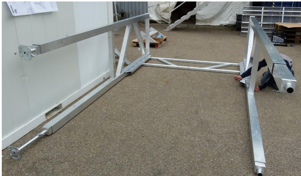
Abb. 29: Aufbau der Stütze für Zwischengeschoss: Stützen und Verbinder fertig aufgebaut
