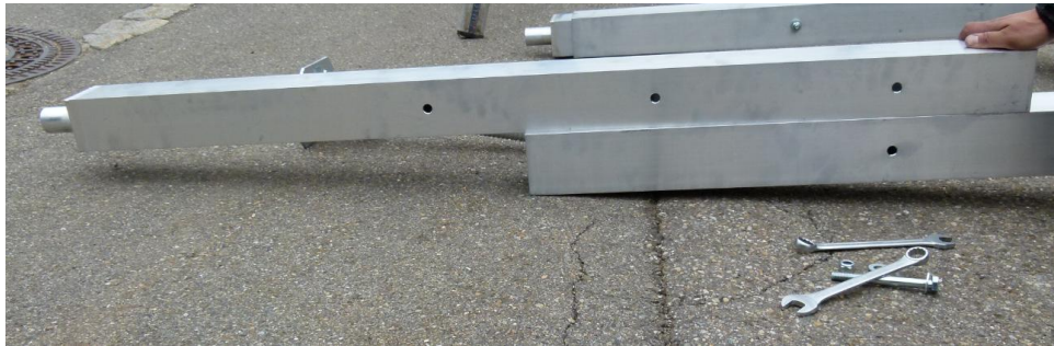
Abb. 26: Aufbau der Stütze für Zwischengeschoss: Höheneinstellung
