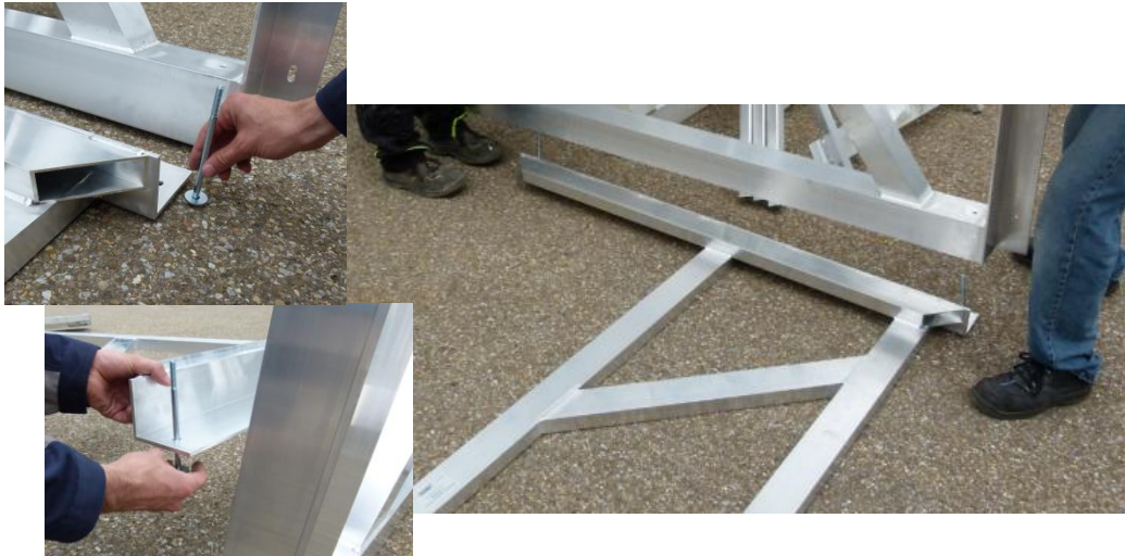
Abb. 27: Aufbau der Stütze für Zwischengeschoss: Vorbereitung
