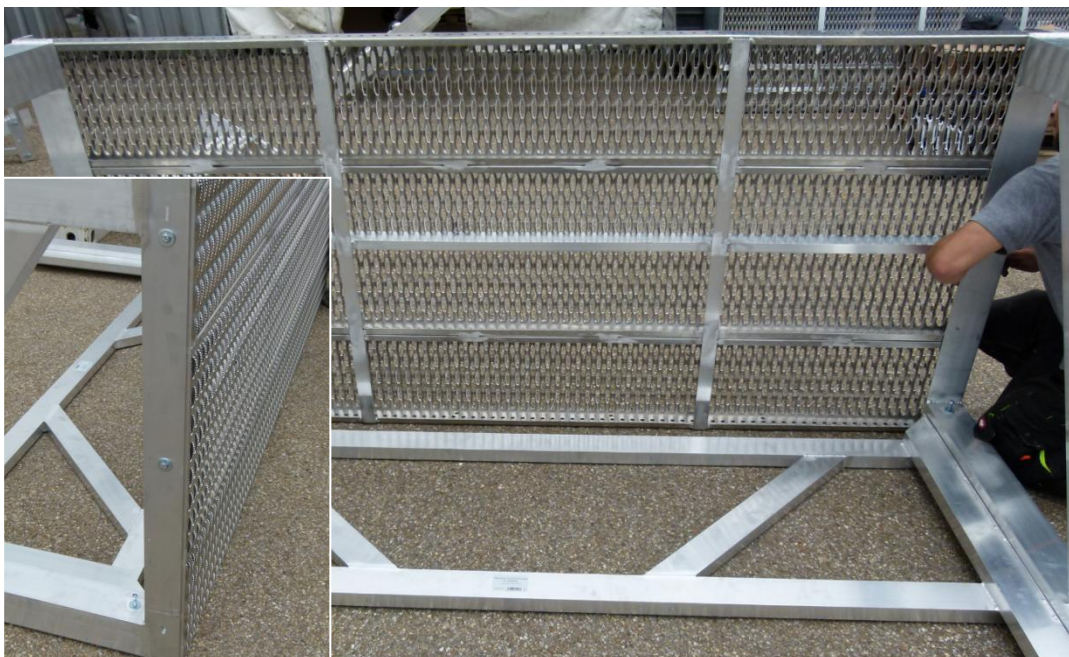
Abb. 31: Aufbau der Stütze für Zwischengeschoss: Laufsteganbau
