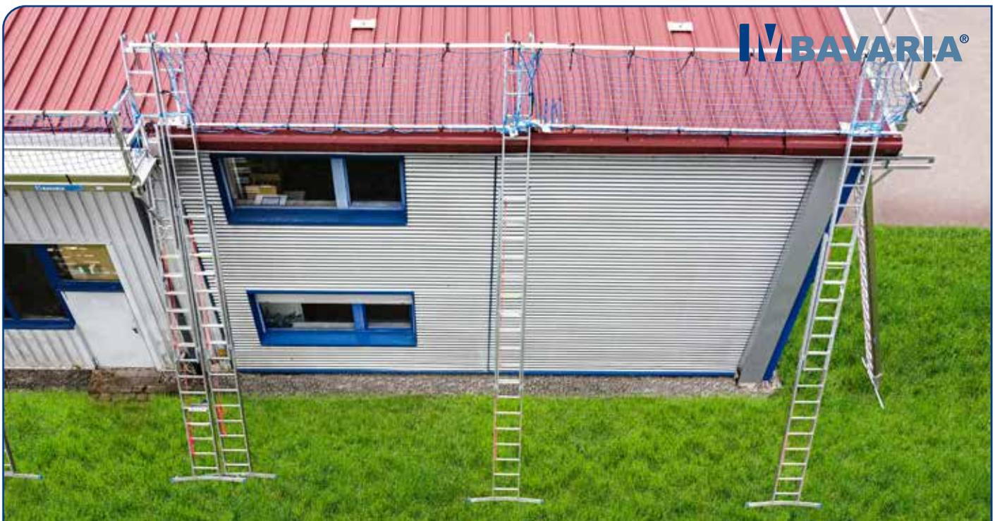
Ab einer Standhöhe von mehr als 5m dürfen Sie gemäß der aktuellen TRBS nicht mehr von einer Leiter aus arbeiten. Die Verankerung der Leitern erfolgt dann vom Dach aus. Je nach den baulichen Gegebenheiten müssen sich die Monteure während Verankerung und Geländer-Montage mit einer persönlichen Schutzausrüstung (PSA) absichern.
